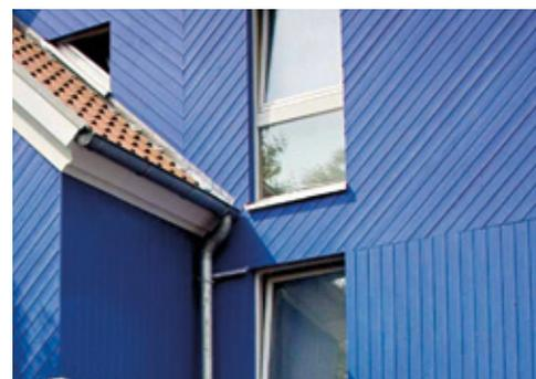
Im Neubauzustand sieht es noch gut aus. Die Kontaktstöße werden hier allerdings zu Schäden führen.
