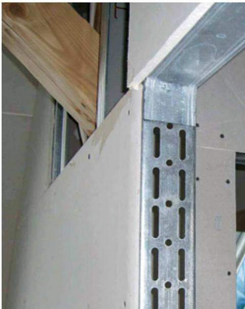
Oben: UA-Aussteifungsprofil für den Türeinbau
