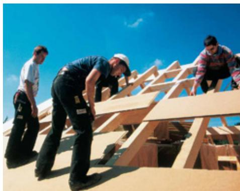
Unterdeckplatte als Dämmung über dem Sparren
