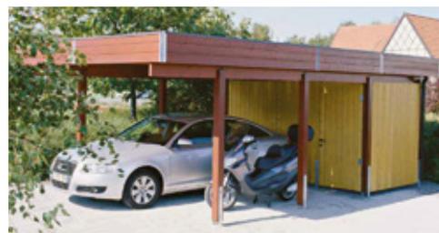
Breitcarport, freistehend mit Dach und Einbaukammer aus Leimholz (Fichte)
