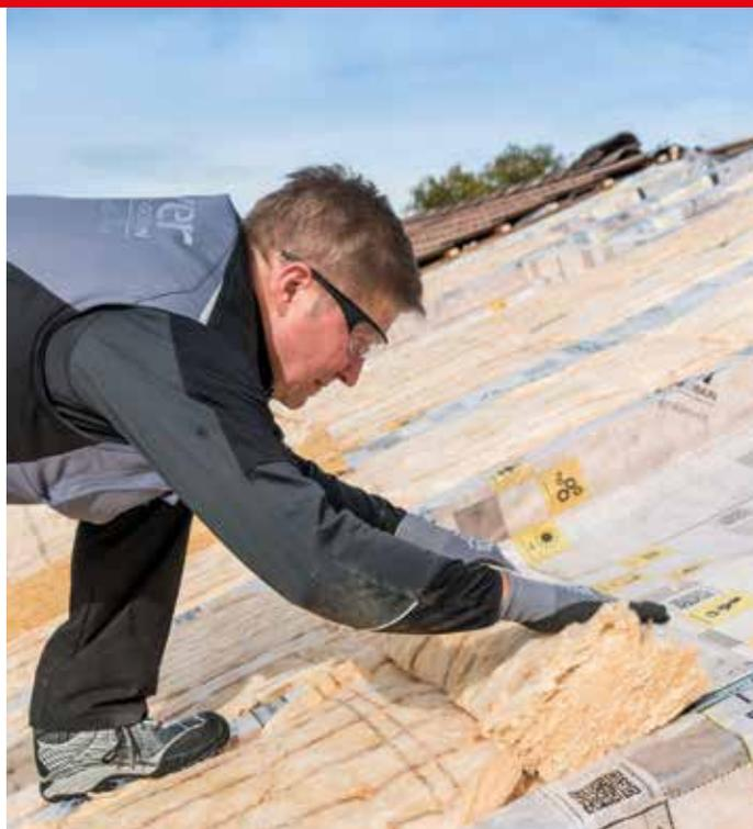
Ebene und schlaufenförmige Verlegung gelten als sicher und gehören heute zum Stand der Technik bei Dachsanierungen. Fotos: Isover
