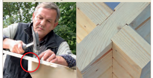
Optimale Auflage der Dachbretter durch abgeschrägte Seitenwandbohle
