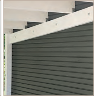
Stabile Dachkonstruktion bei den Seitendächern
