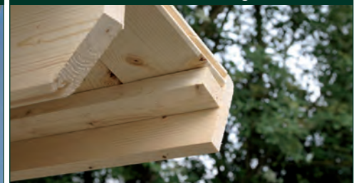
Untere Dachabschlussleiste zur einfachen Dachrinnenmontage
