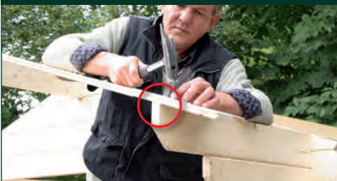
Optimale Auflage der Dachbretter durch abgeschrägte Seitenwandbohle
