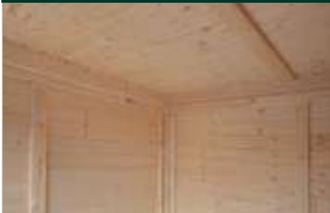
Fertig isolierte Dachelemente, 75 mm
