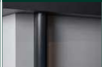
Integrierte Dachrinne / 1 Fallrohr
